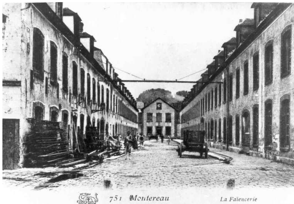
Fig. 19 - La faïencerie de Montereau
