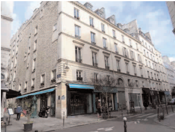
Fig. 23 - Vue actuelle de l'immeuble du 38 rue N-D. de Nazareth, à l'angle du passage du Pont-aux-Biches. Photo Ch. Soudée-Lacombe
