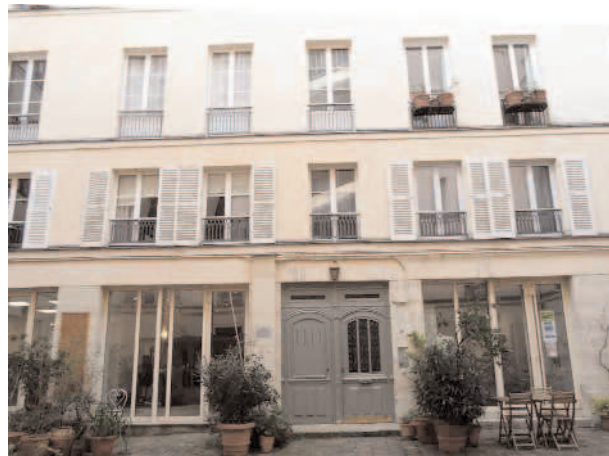
Fig. 24 - Vue actuelle de l'immeuble construit, en fond de cour, à la place de l'ancien atelier du 38 rue N-D. de Nazareth. Photo Ch. Soudée-Lacombe
