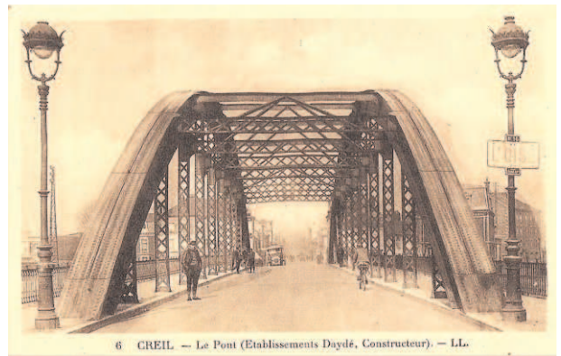
Fig. 4 - Creil : Pont sur l'Oise construit par les Etablissements DAYDÉ.
