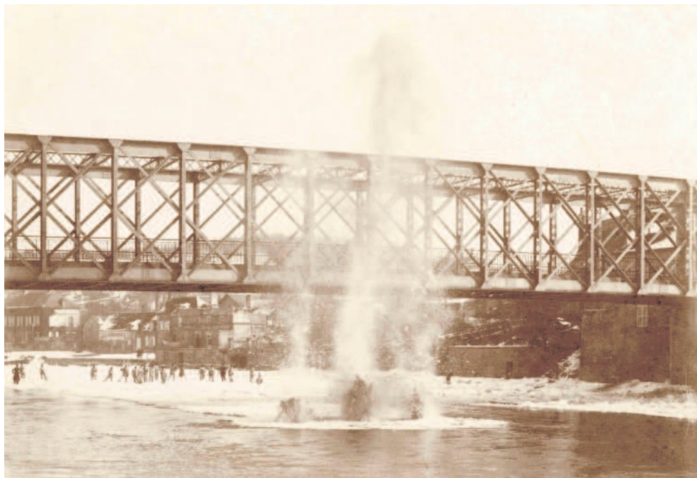
Fig. 4 - Pont métallique de Creil - Hiver 1895
