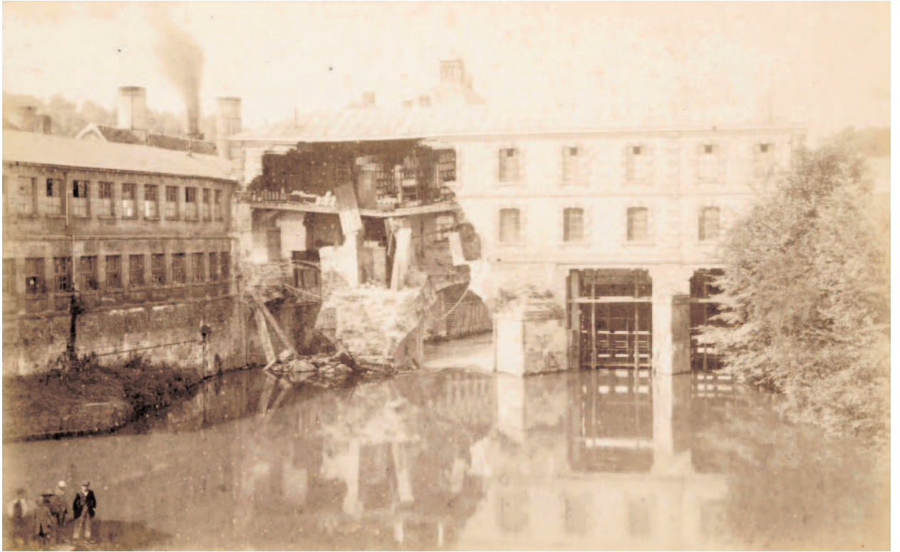
Fig. 3 - Effondrement du pilier sud du moulin de la faïencerie, vers 1890
