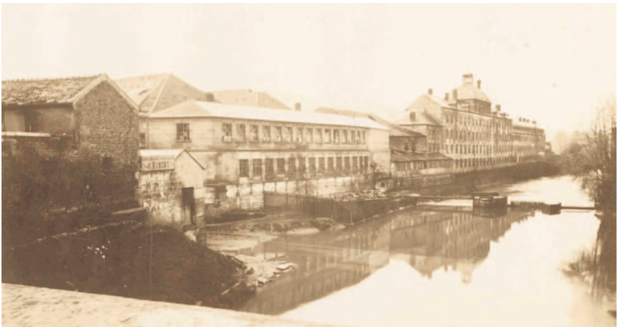
Fig. 28 - Cette photographie de la faïencerie en 1897 semble bien avoir servi de modèle pour la gravure de Ch. Hamlet
