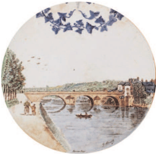
Fig. 12 - L'ancien pont tel que figurant sur le plat
