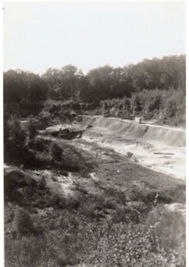
fig. 5 - Vue générale de la carrière vers 1950.
