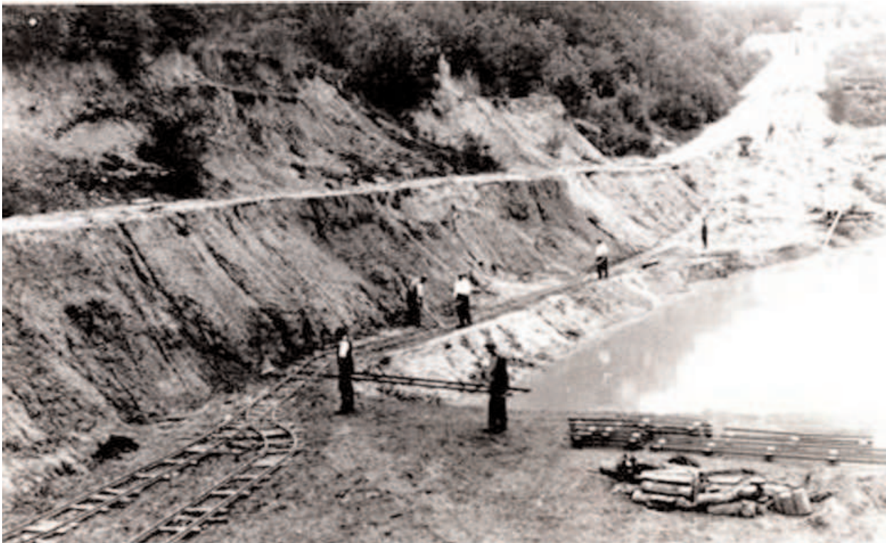
fig. 4 - Les rails pour remonter les wagonnets sur le plan incliné, avant 1914.
