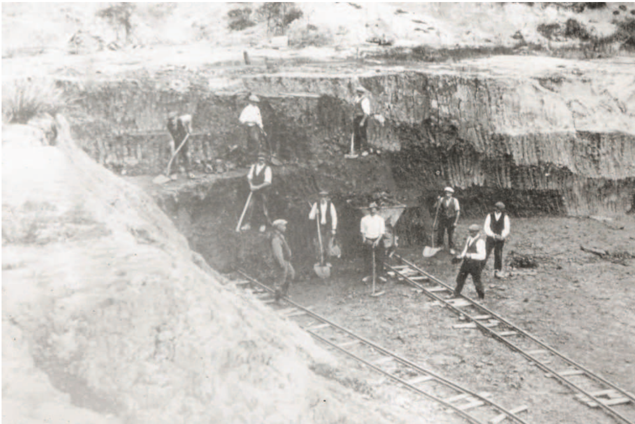
fig. 2 - Les trois niveaux du front de taille de la carrière d'argile ; chargement des wagonnets à la pelle.
